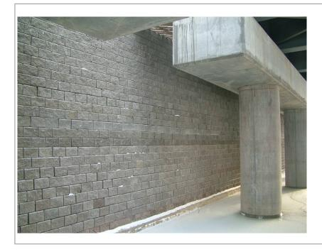
Строительство устоя моста с раздельными функциями, армированного одноосными георешетками Тенсар
