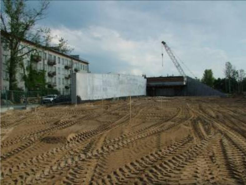
Строительство армогрунтовой подходной насыпи к путепроводу через КАД с одноосными георешетками Тенсар.
