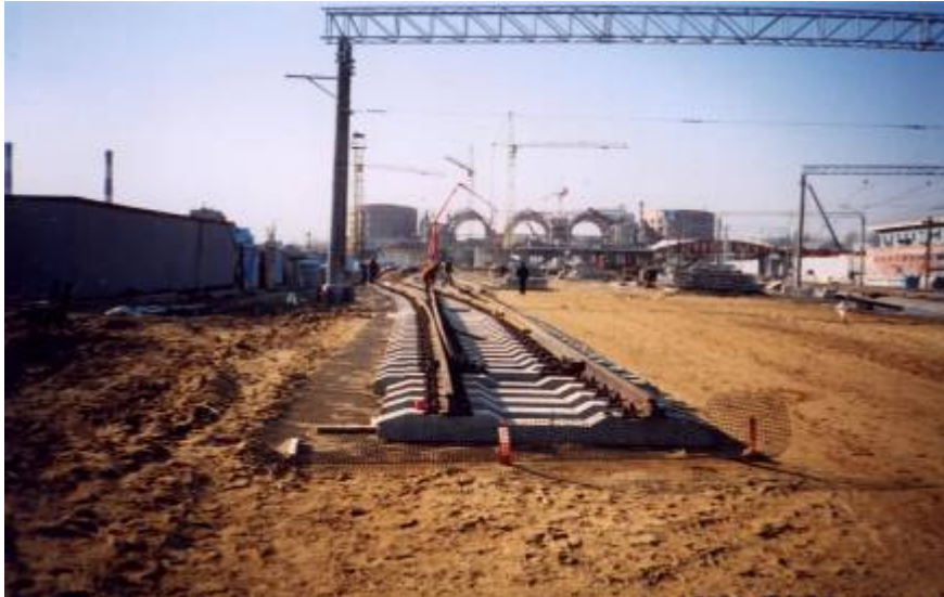
Армирование балластного слоя железной дороги
