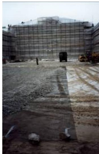
Укрепляются несвязанные между собой слои дорожных одежд. Инертный материал уплотняется над георешеткой, его частицы проникают сквозь отверстия георешетки и фиксируются, создавая эффект «механической стабилизации». Обладая высокой прочностью, георешетка Тенсар позволяет выдержать высокие нагрузки при очень низких деформациях.
