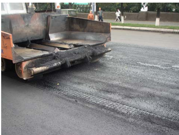
Укладка асфальтобетонного покрытия
