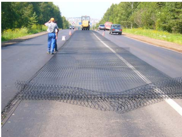
Раскатывание георешетки AR1
